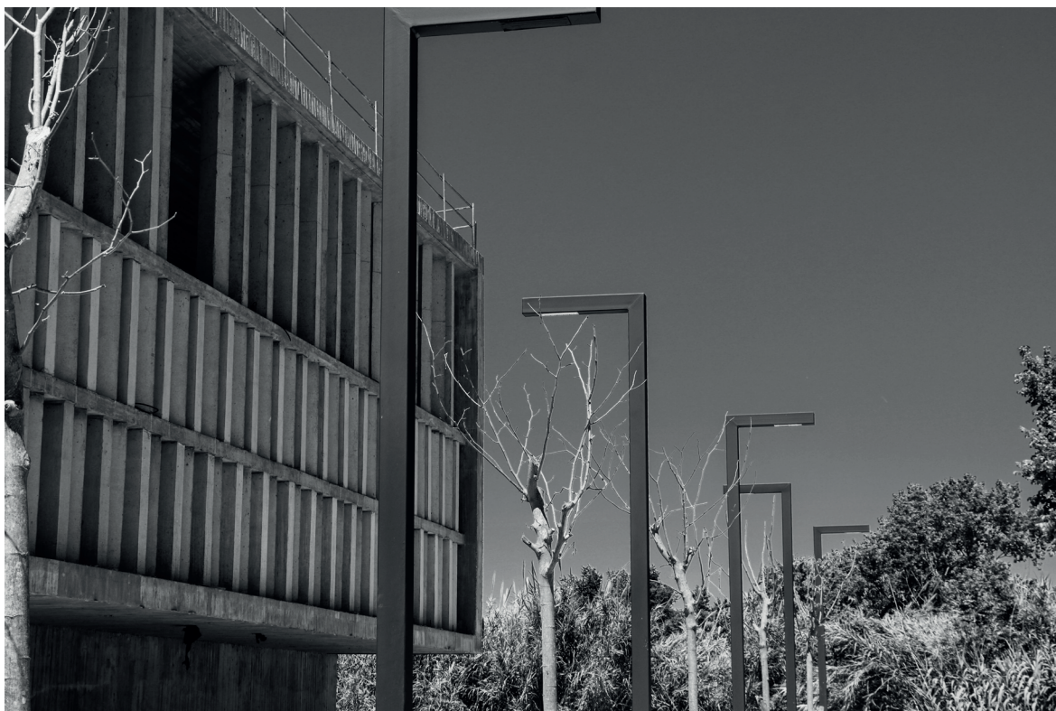
Figura 5. Estacionamiento para residentes bajo la nueva Plaza Balcón del Turia (en construcción). Esta actuación de la EDUSI de Quart de Poblet financiada por la UE permite liberar para uso peatonal cerca de 10.000 metros ocupados por estacionamiento en la calle.
