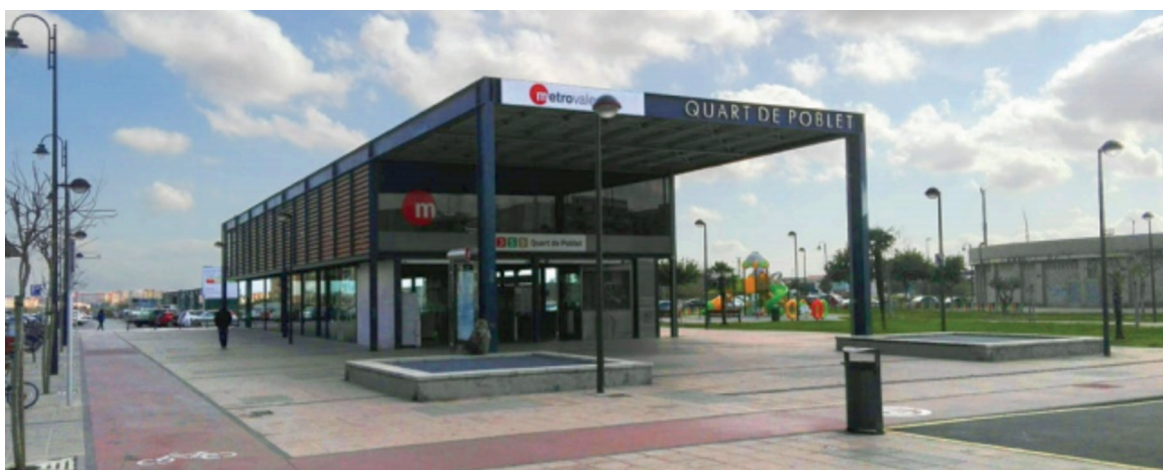
Figura 2. Estación de Quart de Poblet de Metrovalencia. La ejecución de la línea incluyó la reurbanización integral de los antiguos espacios ferroviarios
