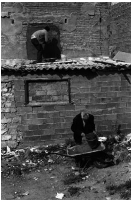
Imatge: Dos homes construeixen una casa a Santa Coloma durant la dècada dels setanta. Fotografia: Joan Guerrero.
