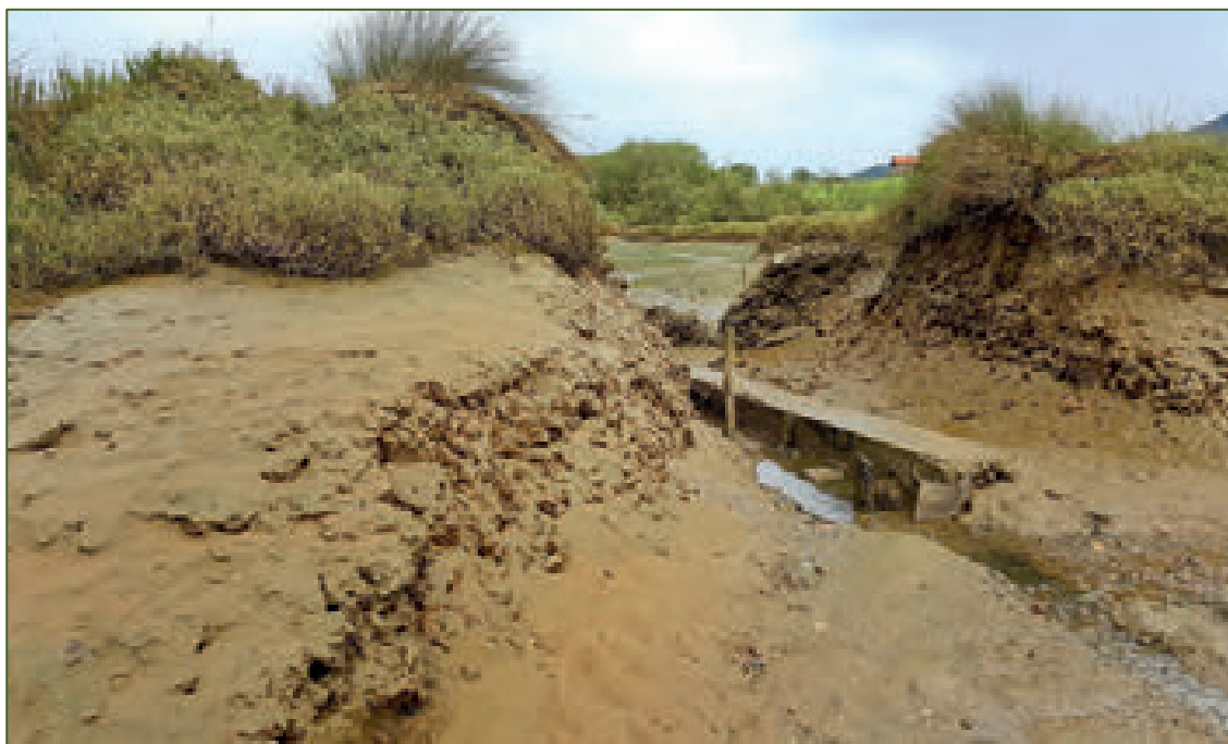
Fotografía 1.2.5. Las marismas de Urdaibai fueron objeto de desecaciones históricas mediante un complejo sistema, hoy periclitado, de diques, esclusas y drenajes. Fotografía de los autores.
