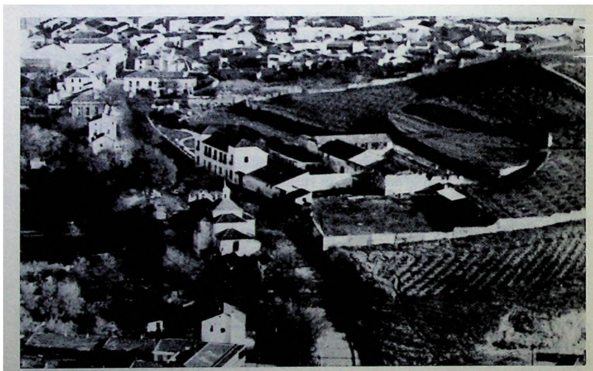
Vista aérea de la Casa del Rey, 1968. (Fotografía cedida por Jesús A. de la Torre Briceño.)
