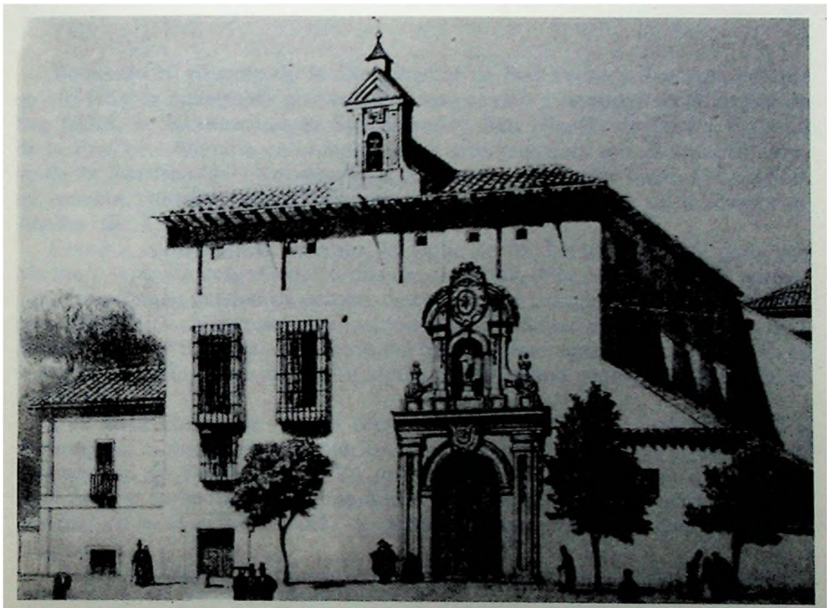
Convento de S. Pascual. Fachada.
