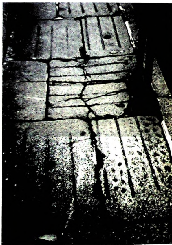
Foto 7: Acera de distintos tamaños de losas de granito, y éste a su vez de diferentes tamaños de grano, en la Cuesta de Santo Domingo
