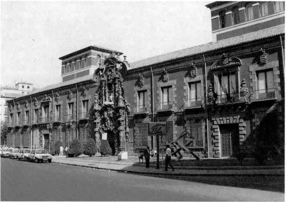
Fig. 4. Estado actual de la fachada principal.
