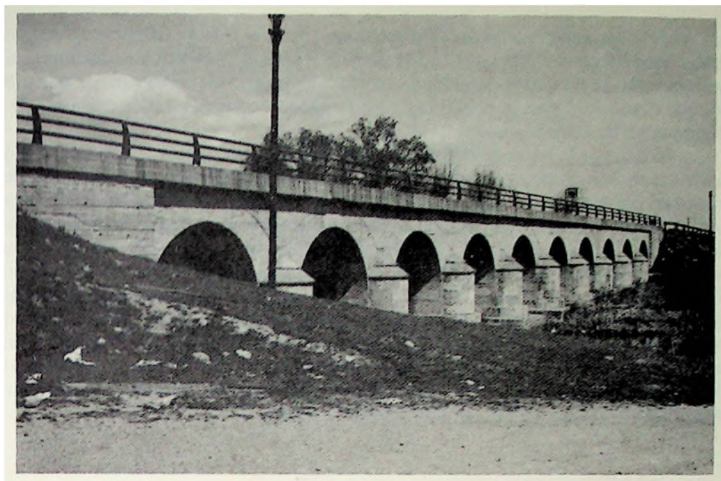
Fig. 6. Estado actual del puente de Torote.
