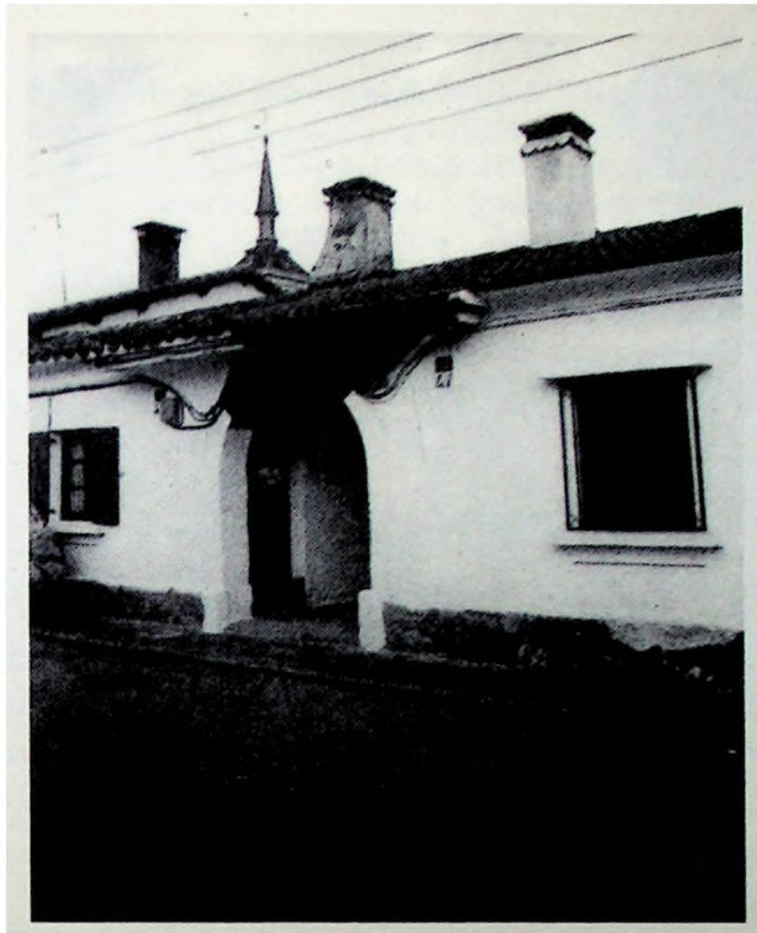
Foto 1.- Vivienda tipo 1-A.
