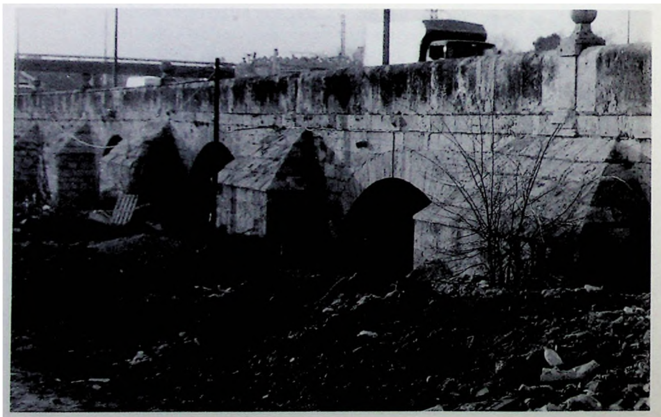
Madrid. Puente de Viveros: pretil y lateral derecho dirección a Alcalá de Henares.
