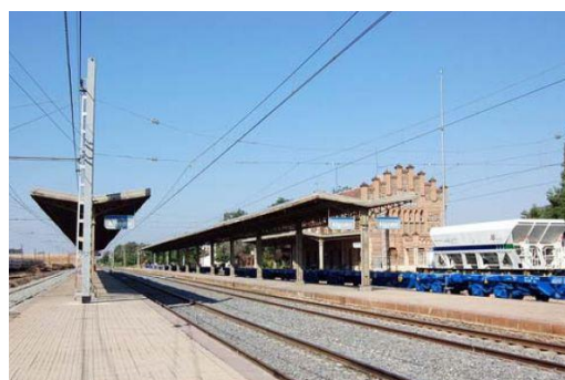
Estación de Algodor
