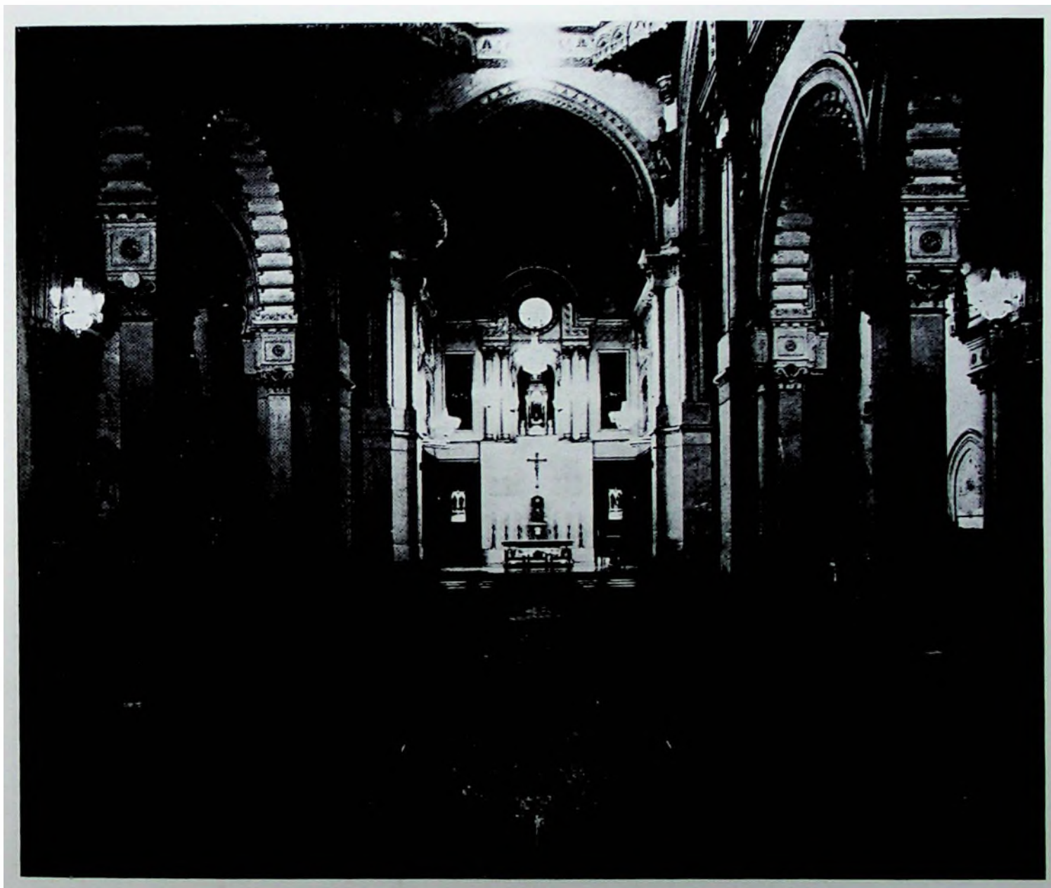
Interior de la iglesia de Nuestra Señora del Buen Suceso. Nave central y Capilla Mayor. (Demolida.)
