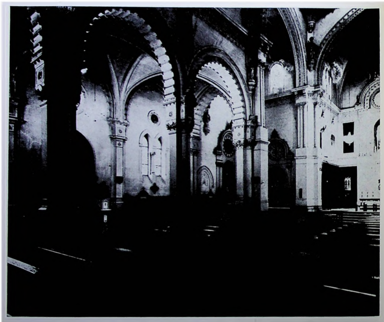
Interior de la iglesia de Nuestra Señora del Buen Suceso, de Ortiz de Villajos. (Demolida.)
