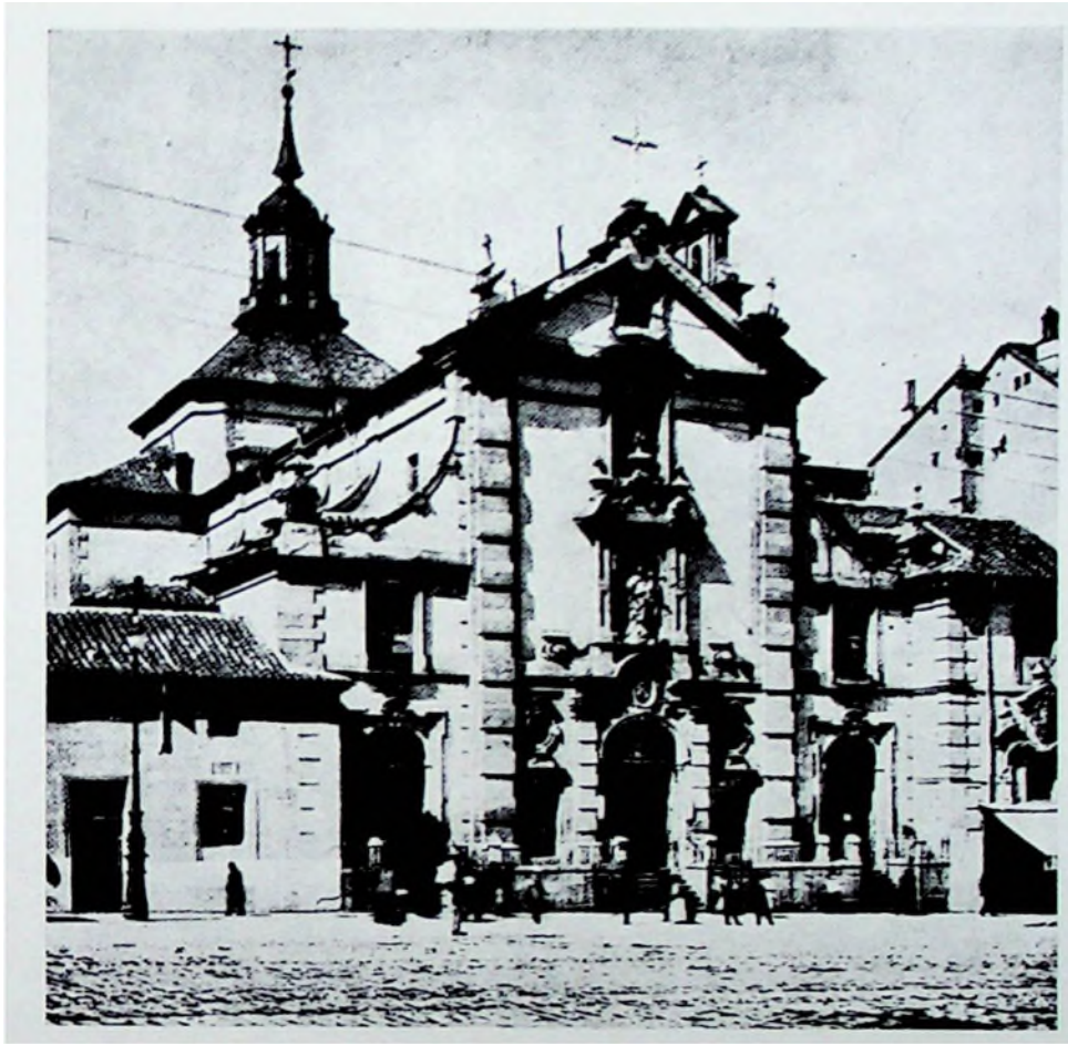
Fachada de la iglesia parroquial de San José antes de su restauración.
