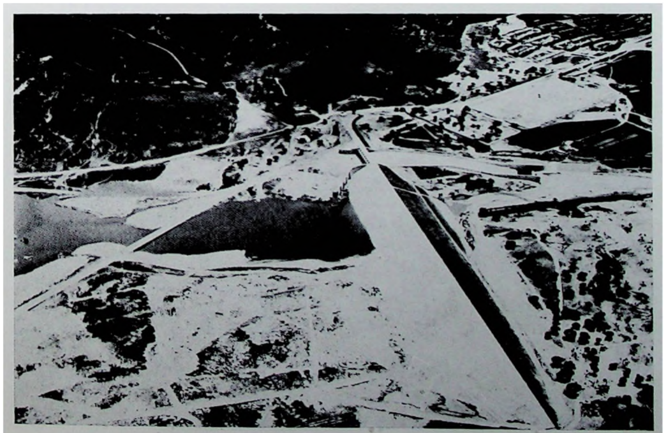
Embalse de El Pardo en su fase de construcción. Pertenece al sistema de regulación del tramo medio del río Manzanares. Este embalse ha inundado en parte la explanación de la antigua Carretera de la Sierra. (Foto: Paisajes Españoles.)
