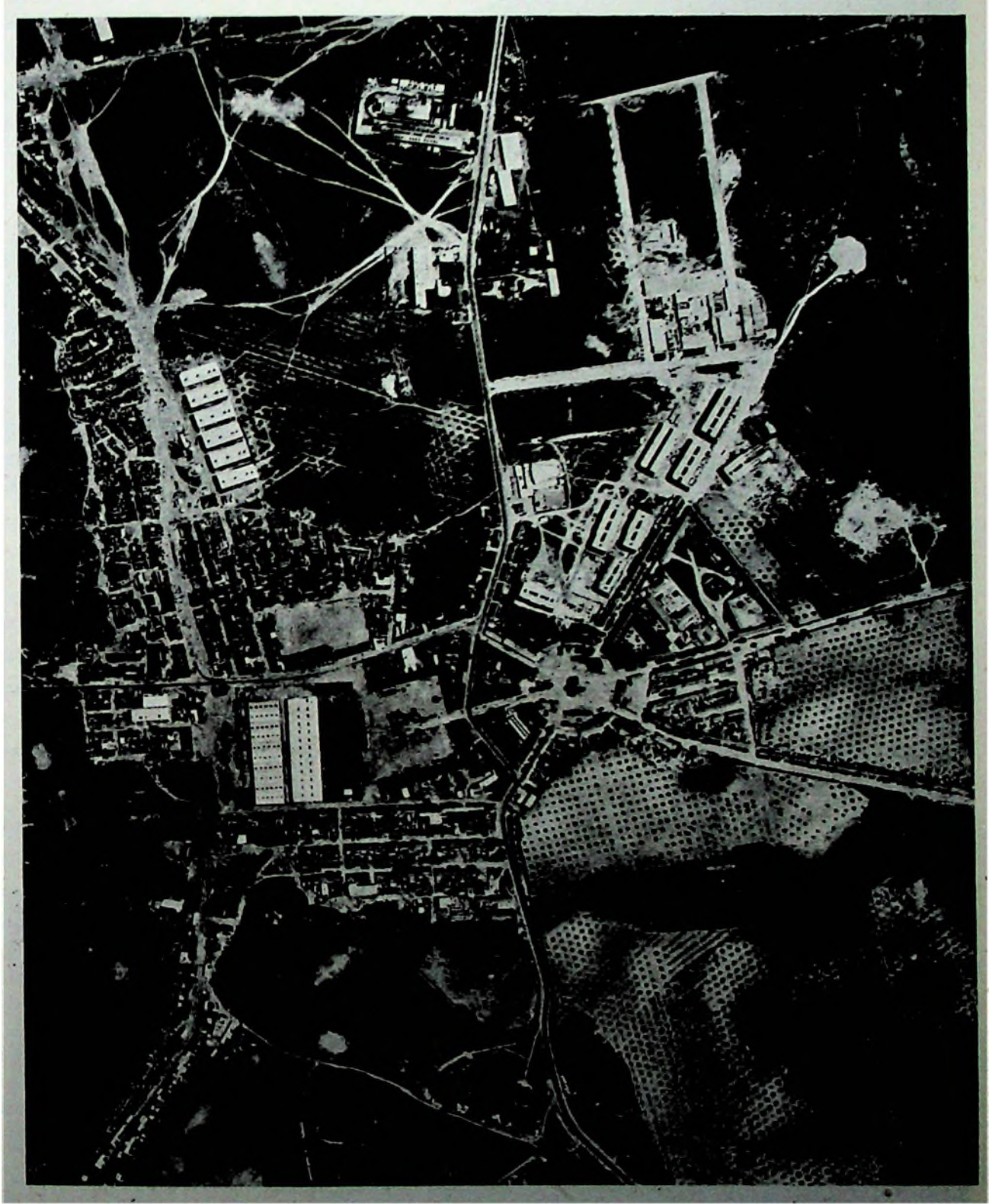
Vista aérea del conjunto.
