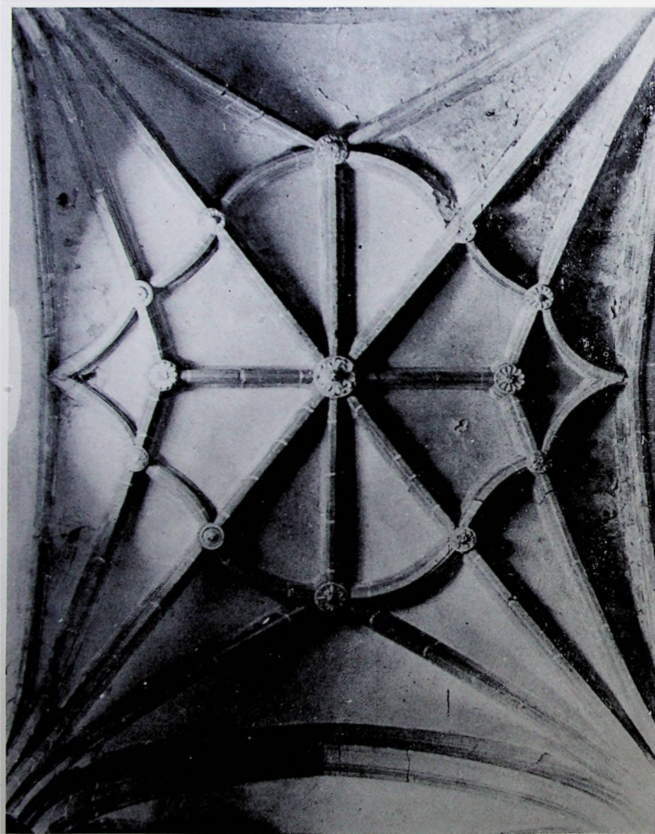
FOT. 8 Meco. Iglesia parroquial. Bóveda nave lateral.
