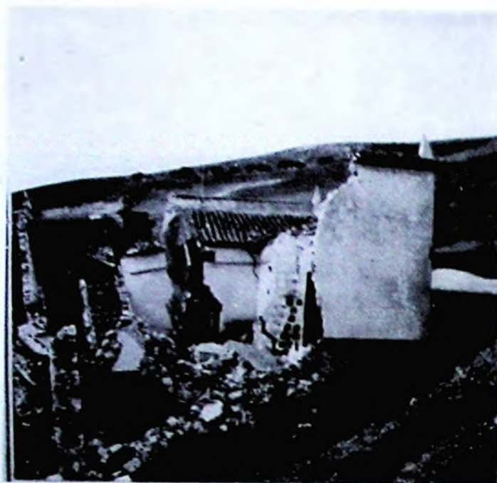
FOTOGRAFÍA N.º 5 Detalle del edificio arruinado junto al camino de Pezuala de las Torres, por los corrimientos del terreno.
