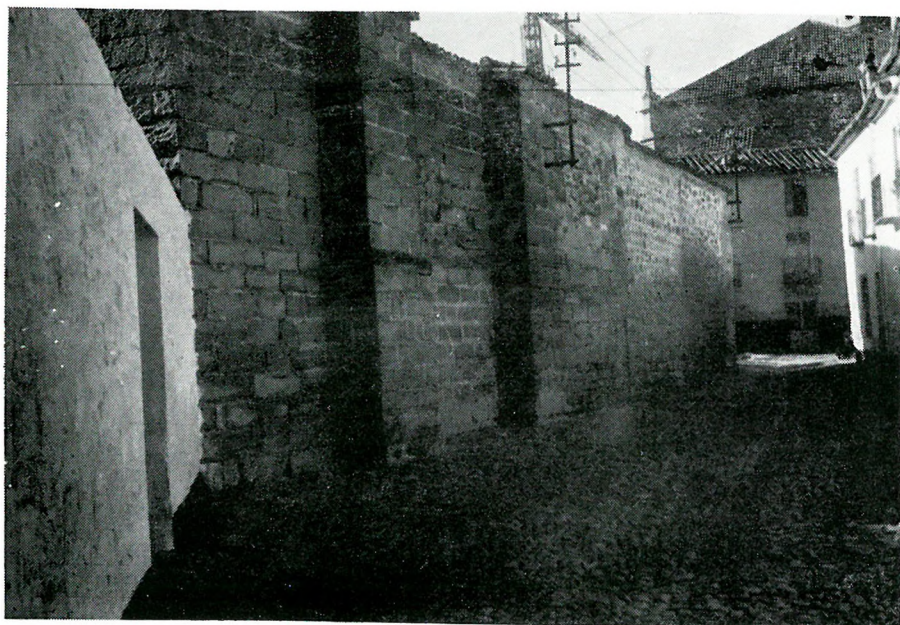
IGLESIA DE SAN JUAN BAUTISTA MURO NORTE
