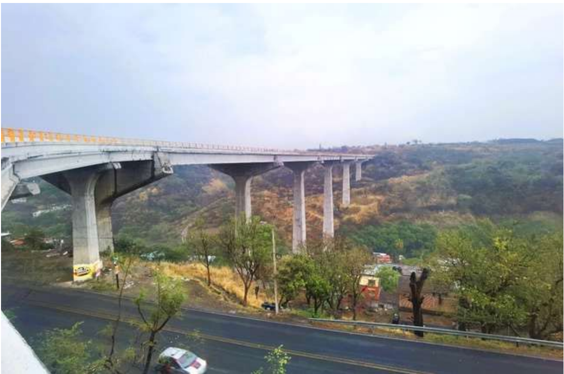
Figura 9. Puente Apatlaco, vista de Cuernavaca hacia Temixco, que evidencia la inconclusa conexión con Temixco. Fuente: Fotografía de Geovani Jiménez (2025).
