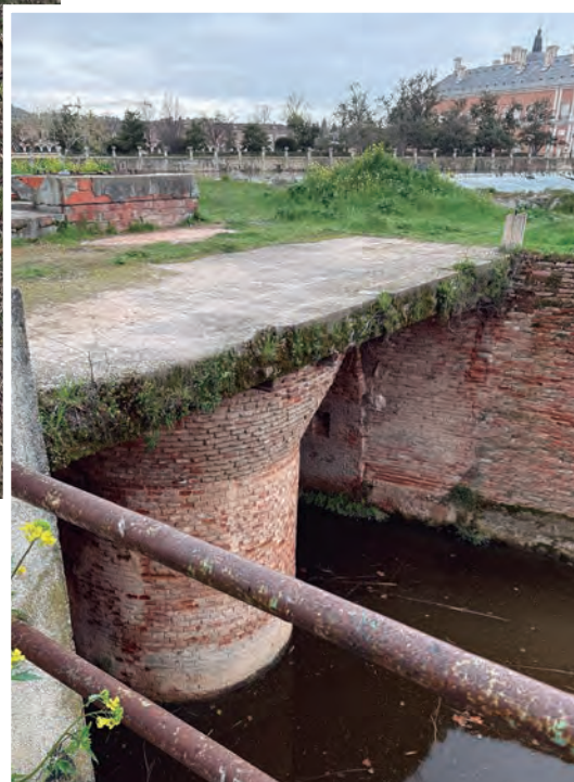
20. La bifurcación del canal Este. Fotografía propia.
