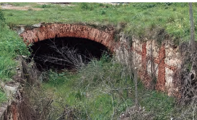
16. Arco rebajado de ladrillo. Fotografía propia.
