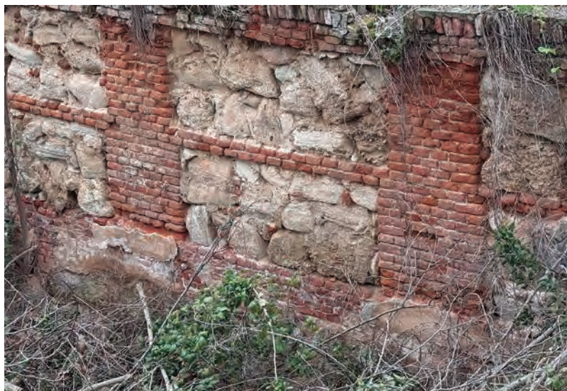
15. Detalle de materiales de los canales. Fotografía propia.
