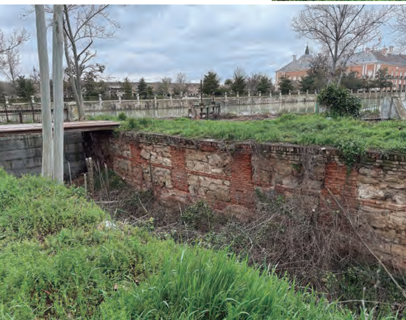
18. Canal Oeste en el tramo cercano al río. Fotografía propia.
