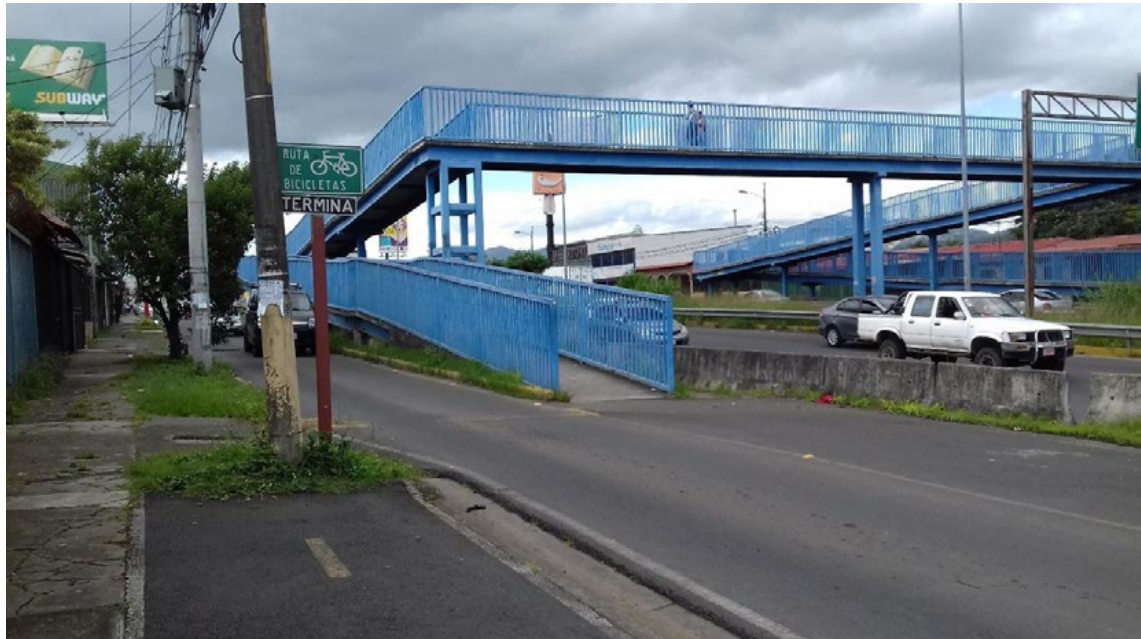
Figura 8. Paso peatonal que desemboca a calle en el anillo de circunvalación, Hatillos, San José. Fuente: Archivo fotográfico personal, elaboración propia.
