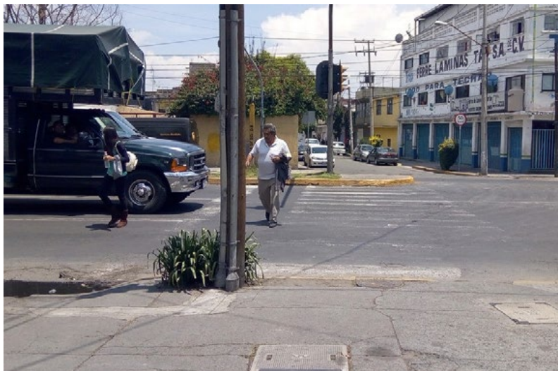
Figura 3. Paso peatonal deteriorado por falta de mantenimiento. Pueblo de Santiago Atzacualco, Ciudad de México. Fuente: https://geoweb.geoint.mx/scpi/mapa.html (Pérez López, et al. , 2019).
