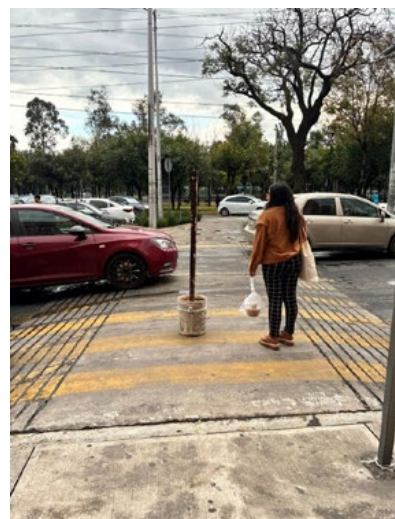
Figura 4. Paso peatonal a nivel de la acera, colonia San Juan de Aragón VII Sección, Ciudad de México. Fuente: Perla Castañeda Archundia.
