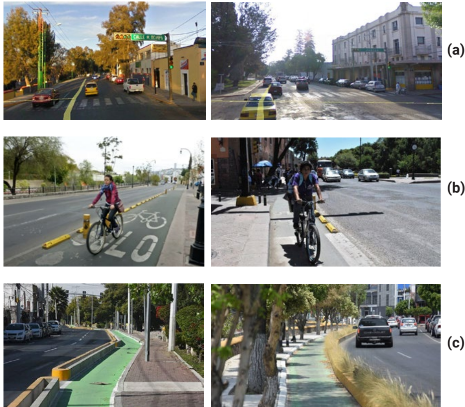
Figura 3. La Avenida Universidad antes y después del carril bicicleta: (a) Antes del carril bicicleta; (b) Con carril bicicleta en el margen derecho; (c) Con carril bicicleta en el margen izquierdo. Fuente: elaboración propia a partir de imágenes de Google Street view.
