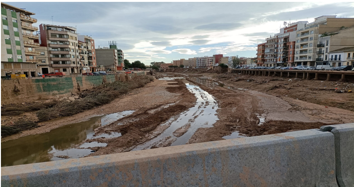
Figura 4. Vista desde el Pont Vell de Paiporta días después de la DANA. Fuente: Sergio Palencia Jiménez.
