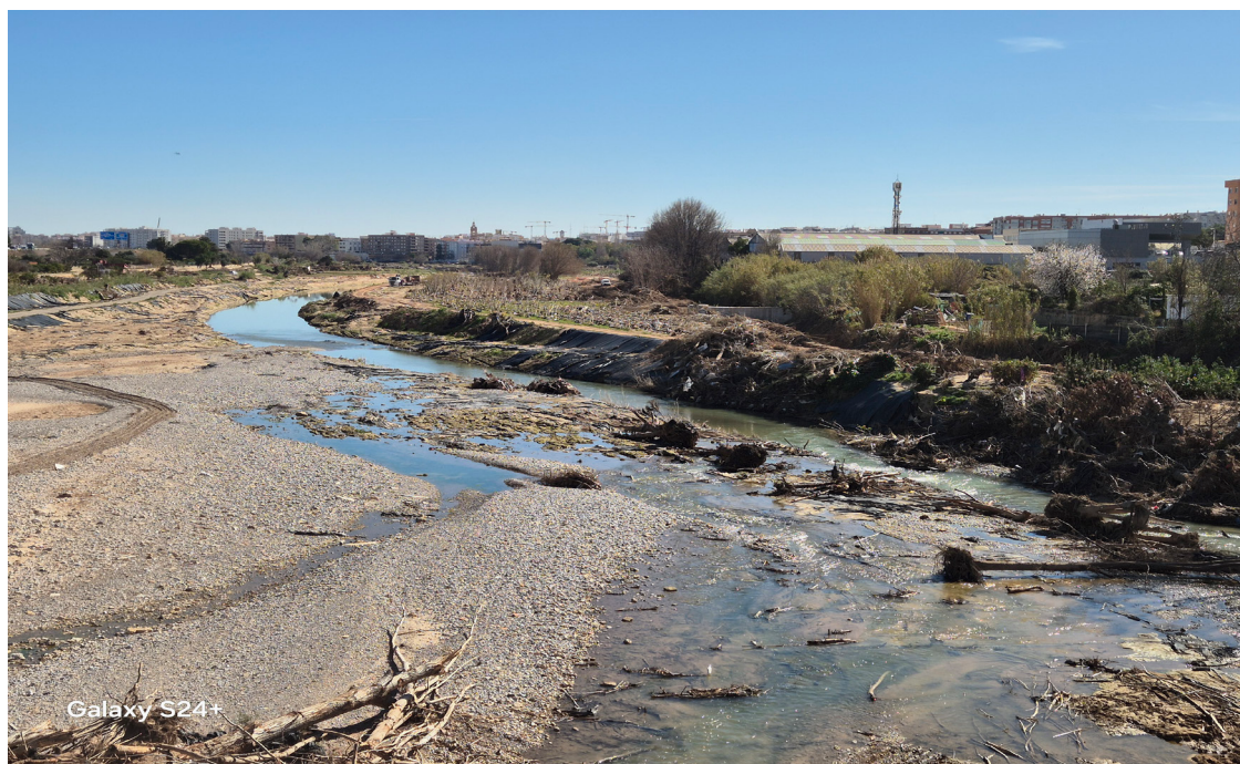
Figura 11: Ribera del río Turia en Manises tras la riada. La necesaria regeneración de las riberas metropolitanas de ríos y barrancos debe incluir la reconsideración de ubicaciones industriales obsoletas, como las que se advierten en la imagen, incluyendo políticas de suelo público que permitan la reubicación y la atracción de nuevas actividades. Fuente: El autor.
