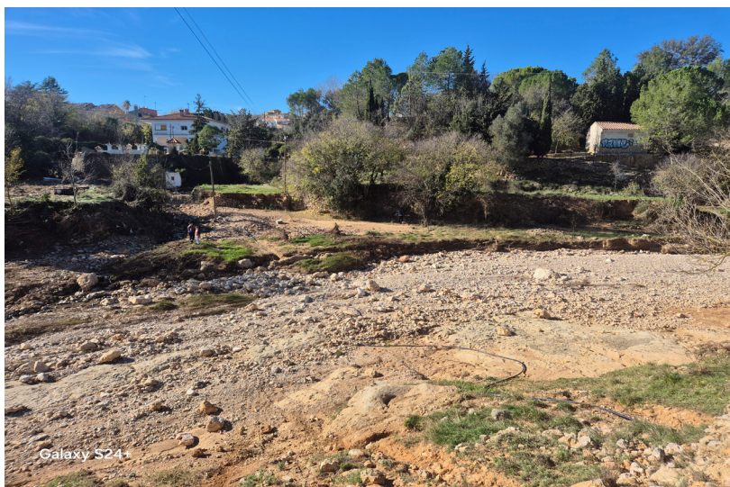
Figura 3. Destrucción del vado de cruce de un camino con la Rambla del Papán, Siete Aguas. El camino conectaba el casco urbano con una serie de viviendas situadas en suelo rústico. No solo quedó cortado el acceso, sino también los servicios que por él discurrían. La tubería que se aprecia en la foto es la reposición de urgencia del servicio de agua potable. Fuente: El autor.
