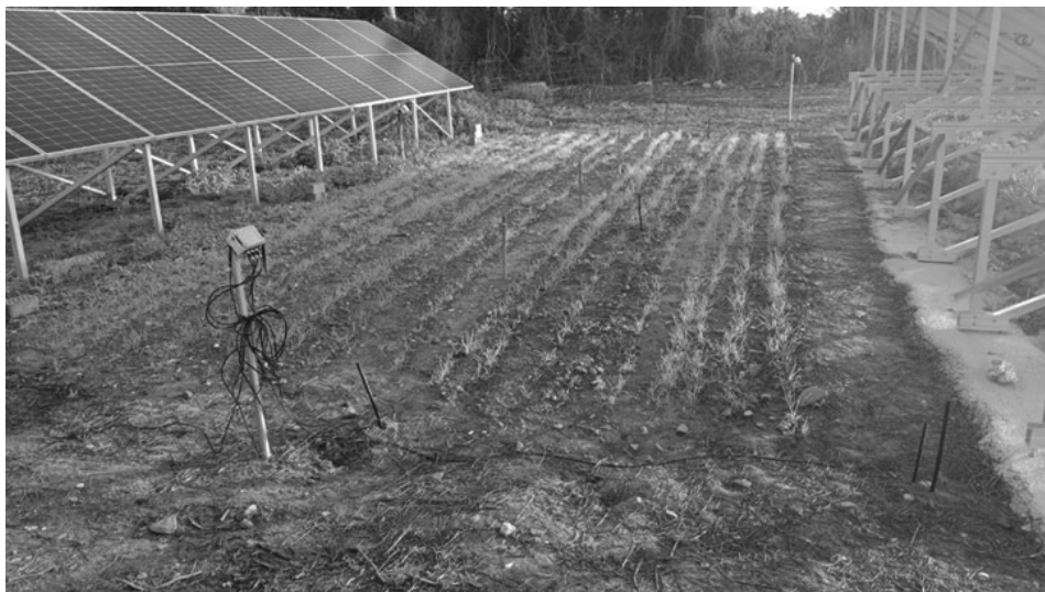
Figura 3. Sistema agrivoltaico abierto entre colectores estáticos
