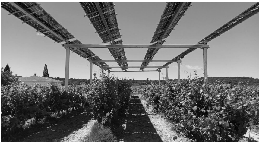
Figura 2. Sistema agrivoltaico en Aranda de Duero basado en seguidores solares sobre estructura elevada sobre cultivo de vid
