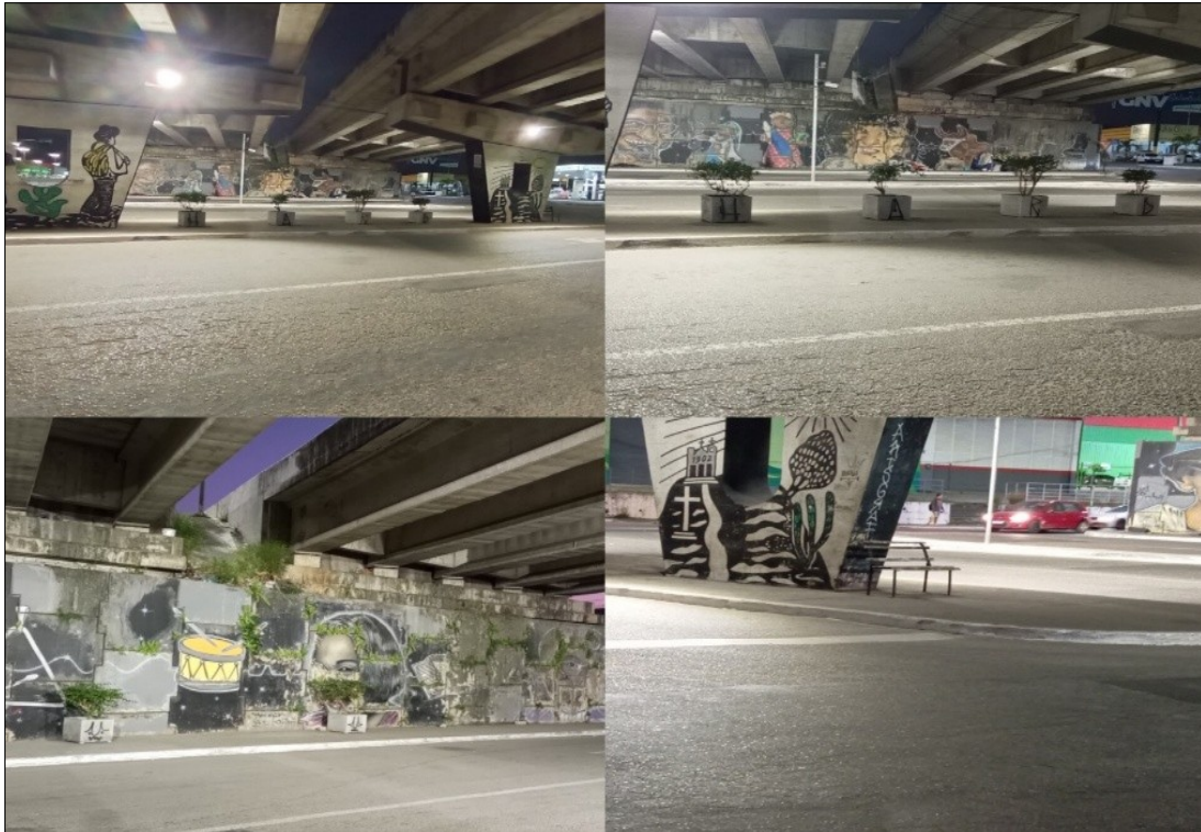
Figura 1 - Avenida dos Estados - Caruaru/PE.
