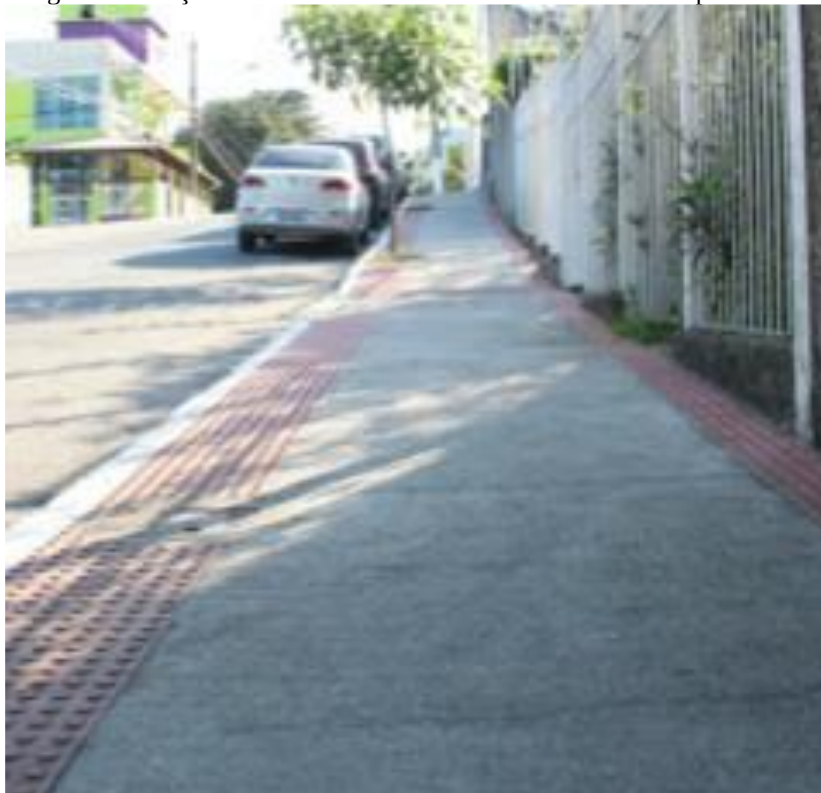
Figura 2 – Calçada acessível com uso de ladrilhos Hidráulicos pisos táteis
