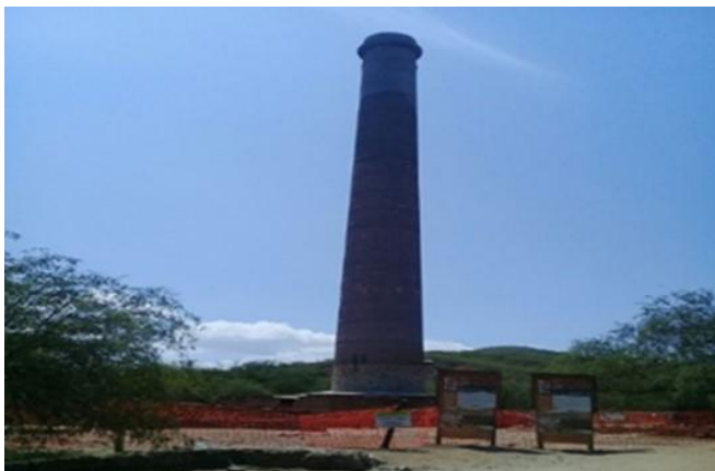
Figura 4. Restauración de la Chimenea La Ramona
