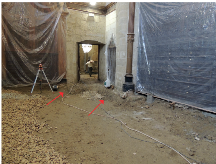
Figura 9. Sacristía nueva. Puerta de conexión con la sacristía vieja. Se observa la situación de la estructura de sillar bajo los lienzos.
