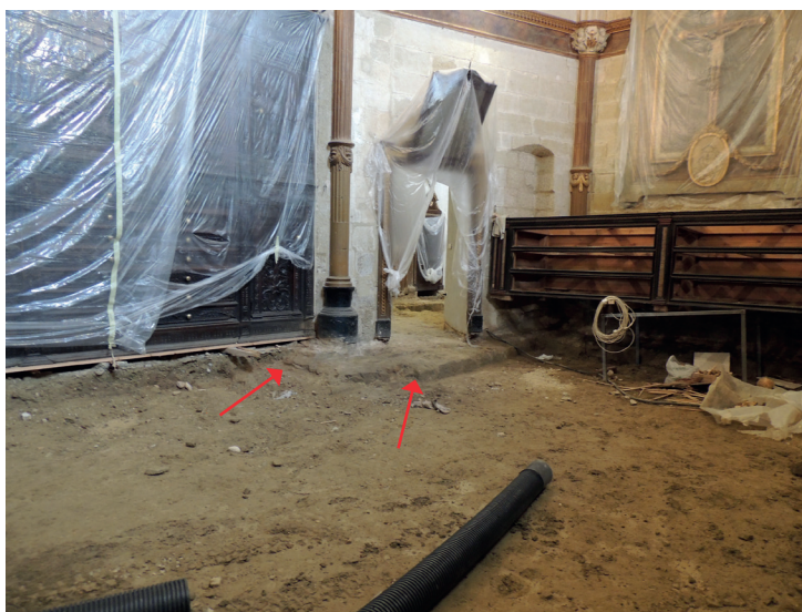
Figura 10. Sacristía nueva. Puerta de conexión con el oratorio de santa Engracia. De nuevo se observa con claridad que los muros de la catedral se asentaron sobre una gran construcción de sillar.
