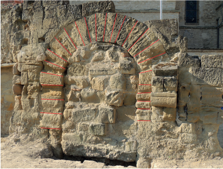
Figura 29. Arco de herradura. Este último testigo de las construcciones previas al claustro románico del que en su día formó parte se conserva muy alterado por intervenciones posteriores y dañado por la erosión.
