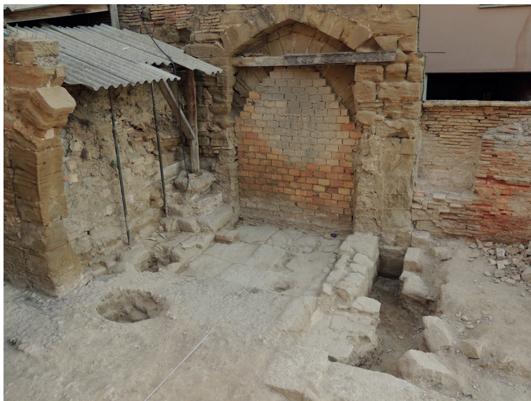
Figura 27. Cata 9. Enlosado en el acceso a la casa de la prepositura.
