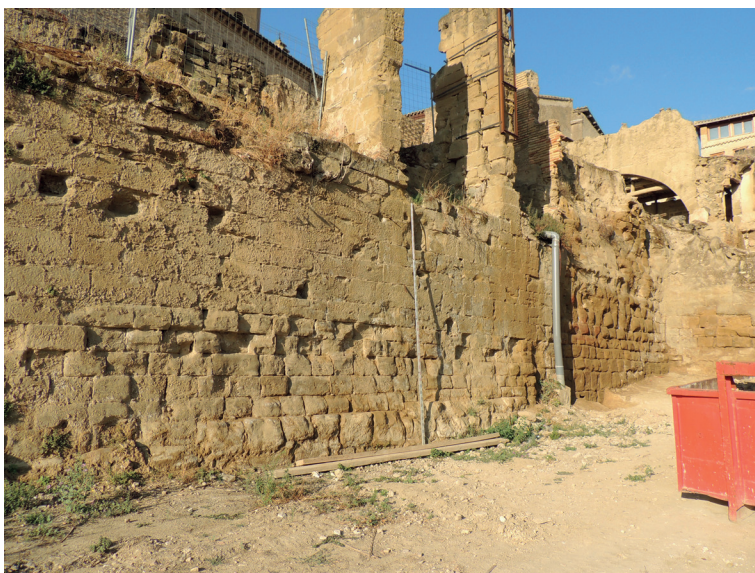
Figura 28. Lienzo exterior (A en figura 15), interesante paramento que manifiesta diferentes momentos constructivos y que en su día constituiría el muro exterior de las dependencias de los canónigos.
