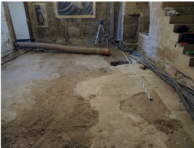
Figura 7. Pavimento de mortero alisado de la sacristía vieja, coetáneo de su construcción, que permaneció en uso hasta que fue cubierto con azulejos o baldosas en el siglo XVI.
