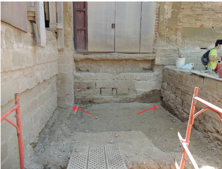
Figura 20. Interior de la cata 5. A derecha e izquierda se observan los lienzos que compartimentan el espacio, contruidos más tarde que los muros exteriores (lienzos A y B en la figura 15).
