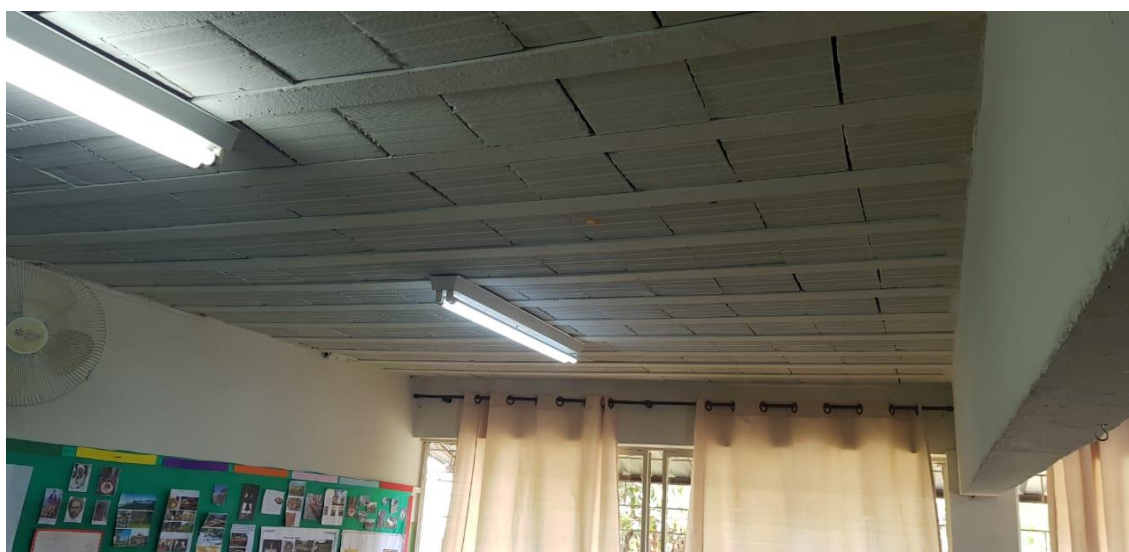
Figura 15 – Rebaixamento da laje no pavimento subsolo do prédio 2.
