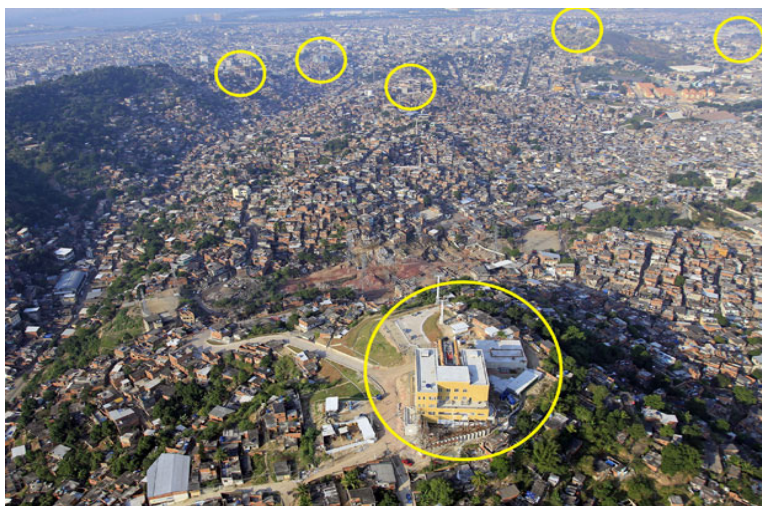
Imagem 2. Foto da malha do Teleférico do Alemão
