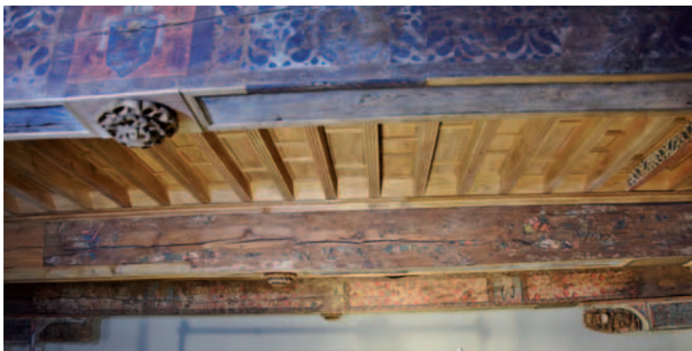
Vista de las últimas vigas recolocadas en la techumbre (XII y XIII). (Foto: Museo Diocesano de Huesca)
