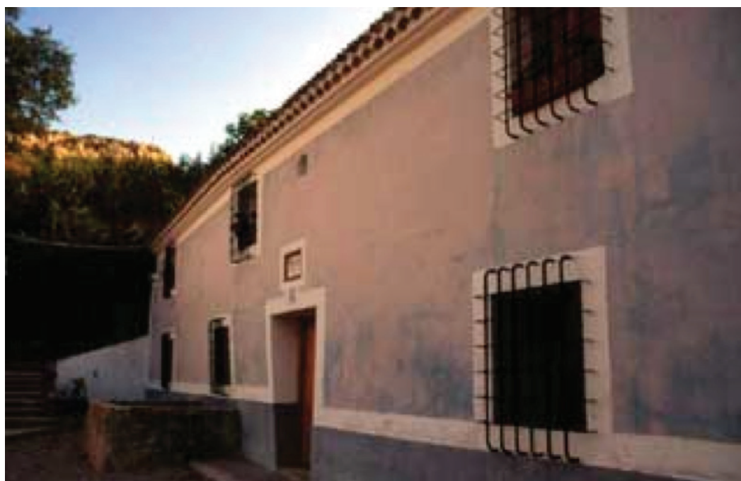
Figura 13. Molino rehabilitado (Bullas)
