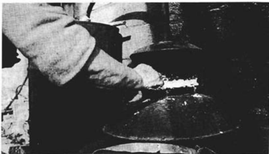
Foto núm. 3: Colocación de la pasta para evitar escapes de vapor.
