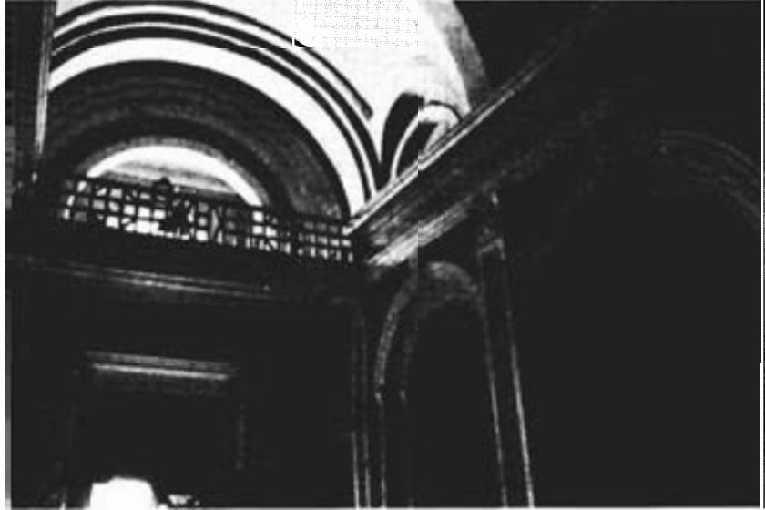
Figura 6. Interior de la nave y coro.
