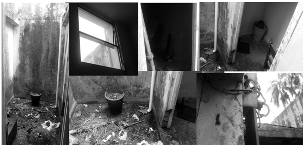
Ilustración 2. Afectaciones en la sede en donde se encuentran almacenadas las fotografías (fuente: elaboración propia).
