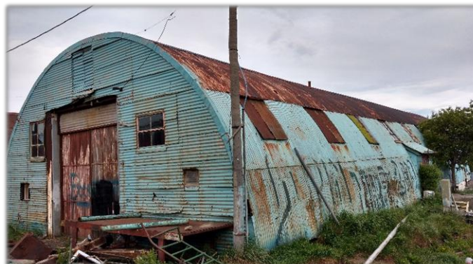
Imagen 24. Edificio Municipal de Río Turbio utilizado como Taller y Depósito.
