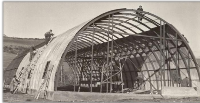
Imagen 12. Montaje de un Elephant Hut en Río Turbio.
