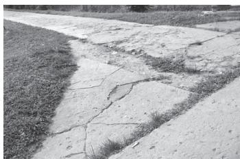
IMAGEN 11. Diferentes grados de fractura de la loza en los caminos
