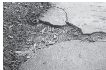
IMAGEN 11. Diferentes grados de fractura de la loza en los caminos
