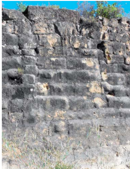
Figura 3. Pantalla de la presa. Sillares almohadillados a soga y tizón en la cara exterior.
