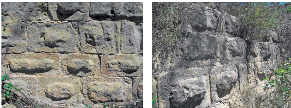
Figuras 5 y 6. Sillares almojadillados a soga en la cara exterior del estribo de la orilla derecha.
