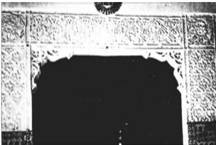
Fig. 14. Vano del patio de los Aljibes del monasterio de la Concepción Franciscana (Toledo).
