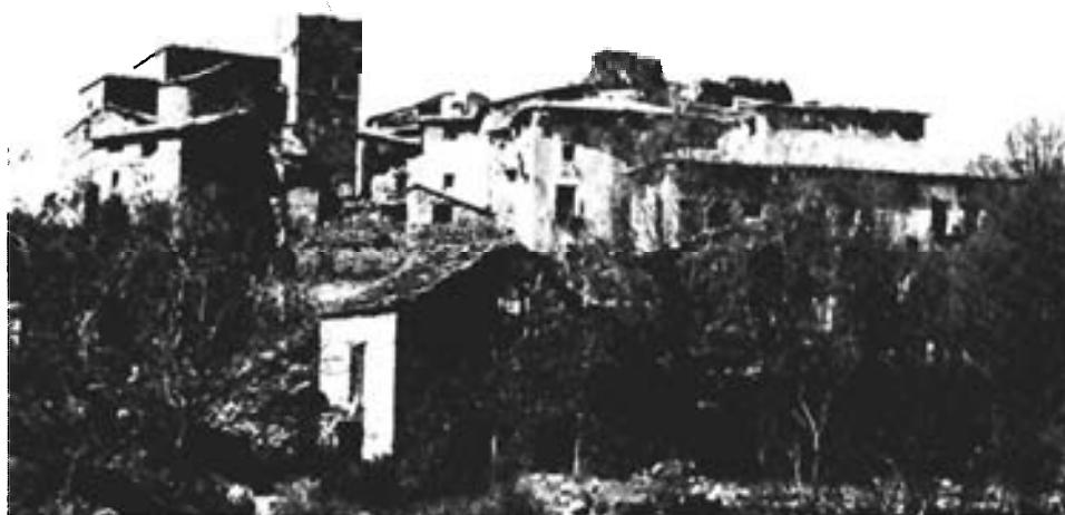
Clamosa. Vista general desde el sur.
