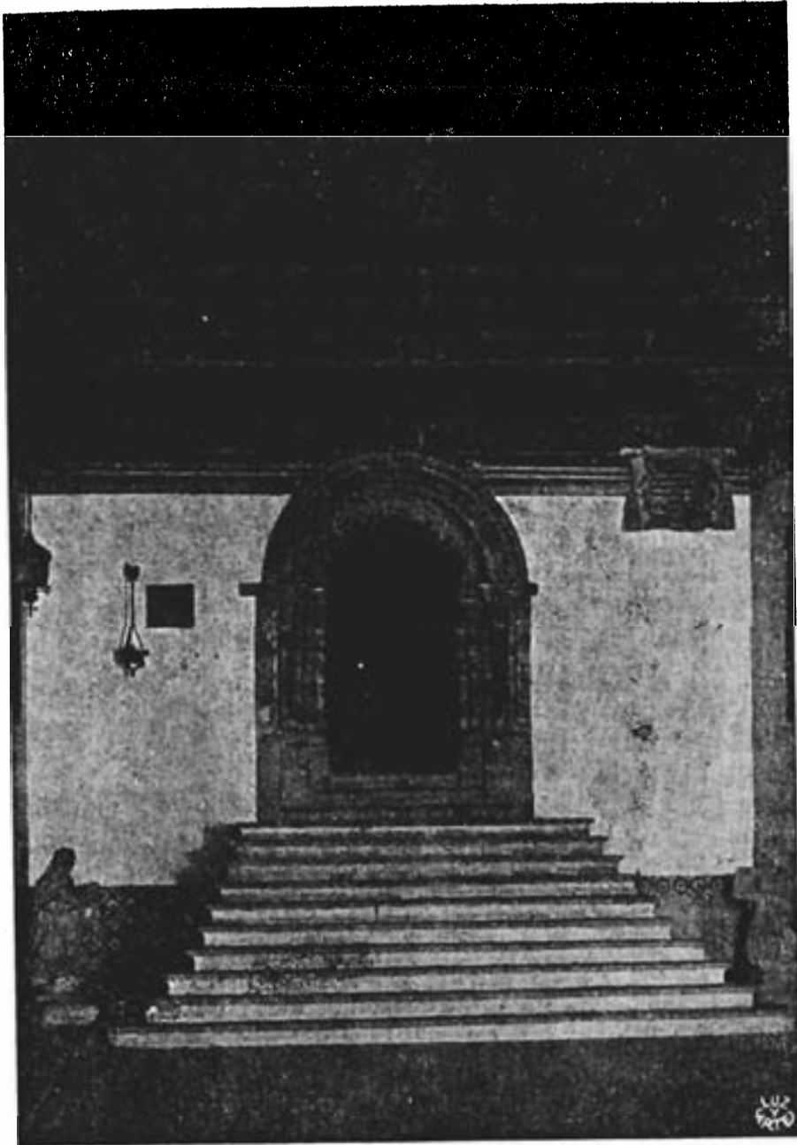
Salón del palacio episcopal, construido gracias a la munificencia de don Antón de Espés, cancelario de la Universidad
