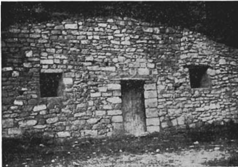
Muro de piedra, de sillares irregulares
