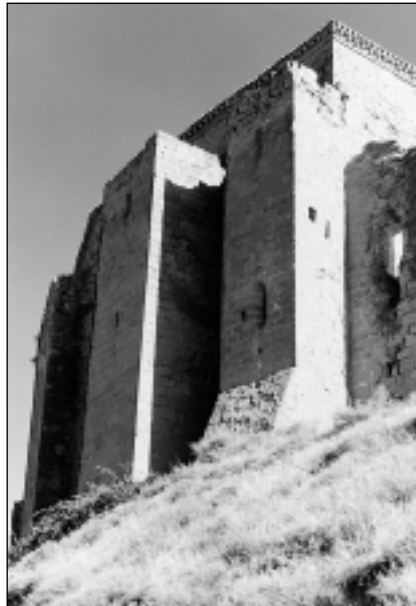
Torres que flanquean como contrafuertes a la iglesia. (Foto B. A. L.).
