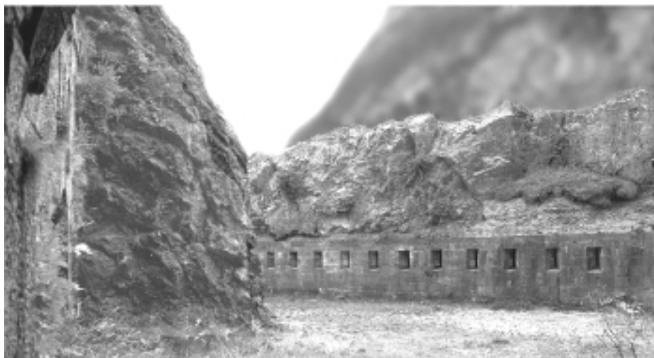
Foso con su galería de contraescarpa. A la izquierda el orejón de roca que protege a la semicaponera.
