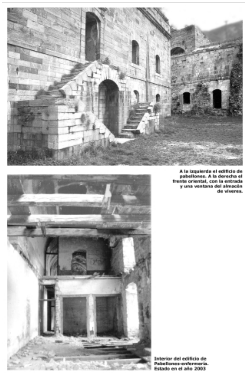
Figura 11. Edificio de pabellones e interior del edificio de pabellones-enfermería.
