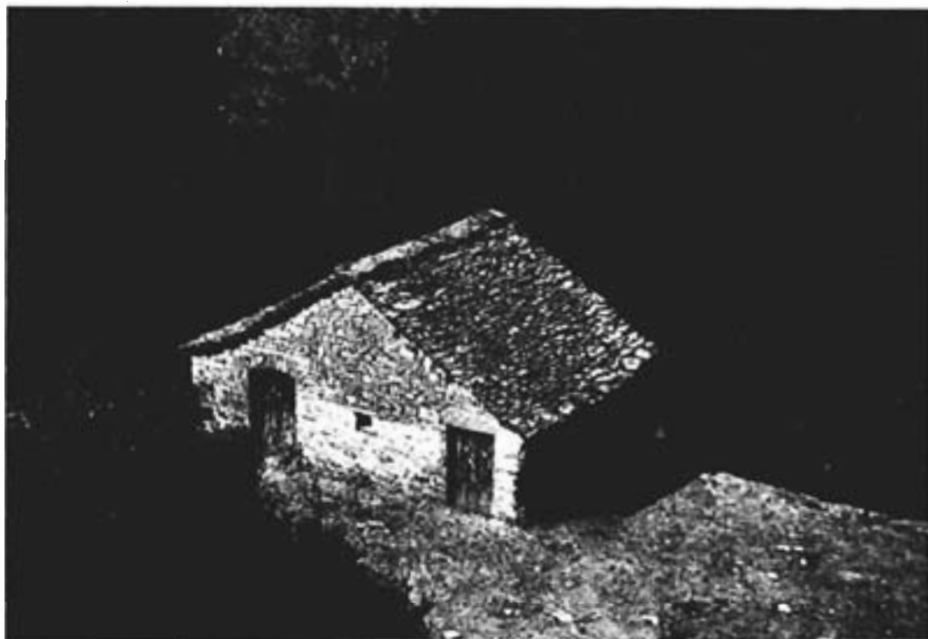
ESCARTÍN: Borda en la era de casa "Navarro". Acomodación de las bordas a una fuerte pendiente.
